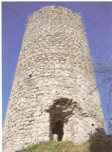
Il est le vestige essentiel de cet ensemble fortifié. On en remarque la maçonnerie soignée, les rares ouvertures aux jambages et linteaux taillés, les chaînages de pierres équarries séparant les trois niveaux de la tour, qui mesure aujourd'hui 19 mètres de haut et 9,50 m de diamètre à la base.
